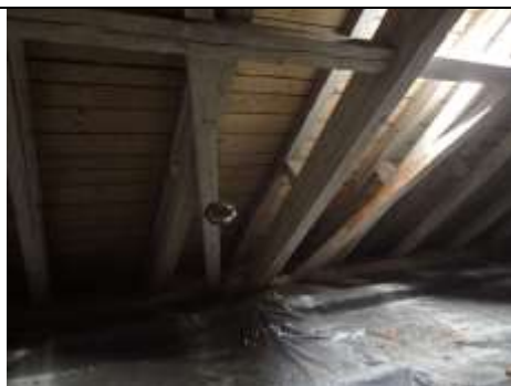
Obr. 6: Vzorkovač umístěný v severní části půdního prostoru divadla v blízkosti vstupu
