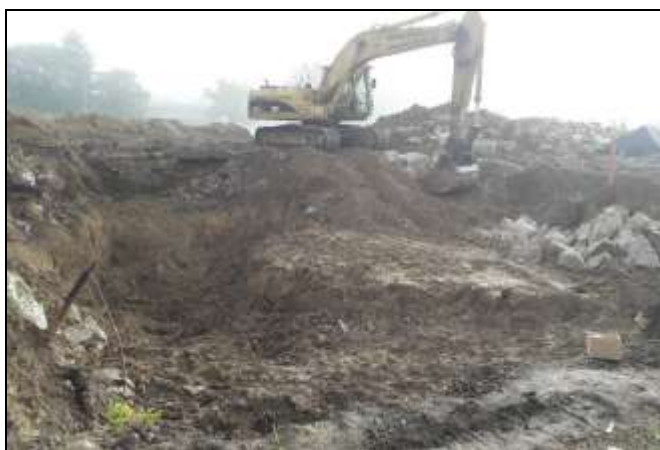
Obr. 8: Odtěžba silně kontaminovaných vrstev zeminy řízená s využitím ED-XRF spektrometru Delta
