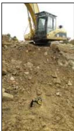
Obr. 8: Odtěžba silně kontaminovaných vrstev zeminy řízená s využitím ED-XRF spektrometru Delta
