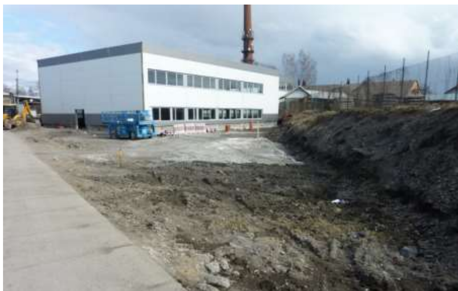
Obr. 1: Provozní budova byla nově vybudována na termicky aktivním podloží
