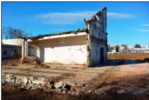
Obr. 6: Objekt bývalé chromovny – demolice
