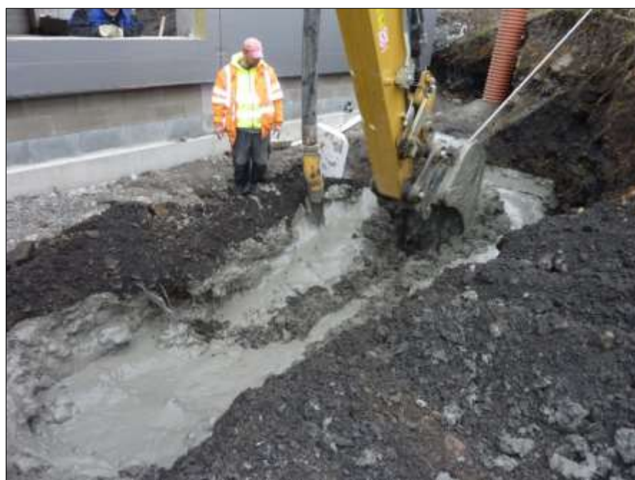
Obr. 4: Zalévání výkopu popílkem a promíchávání s inertní důlní hlušinou
