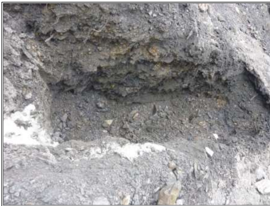
Obr. 3: Výkop pro izolační stěnu, odvoz hlušiny na skládku
