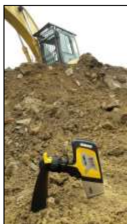
Obr. 8: Odtěžba silně kontaminovaných vrstev zeminy řízená s využitím ED-XRF spektrometru Delta
