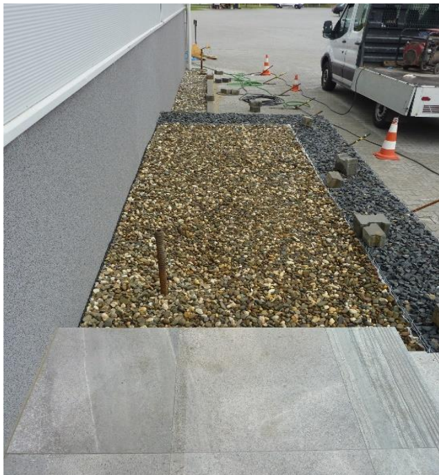
Obr. 8: Pohled na novou termometrickou sondu v prostoru inertizace termického procesu
