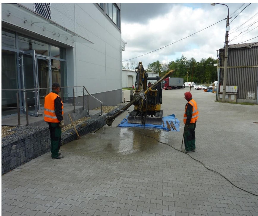
Obr. 5: Instalace injektážních sond z vnější strany budovy
