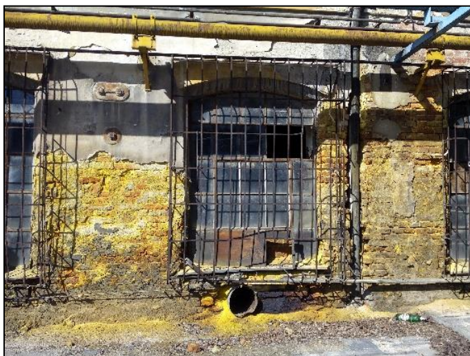
Obr. 1: Kontaminace \text{Cr}^{6+} patrná na zdech chromovny
