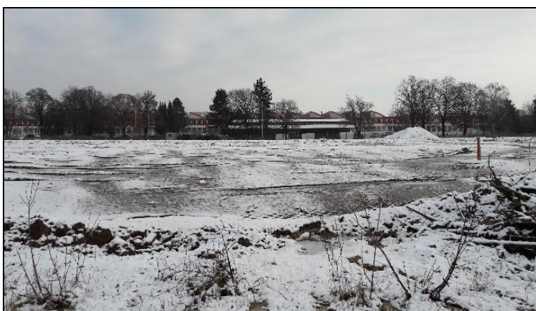
Obr. 4: Vytvoření jílovité nepropustné vrstvy a její zarovnání s okolním terénem
