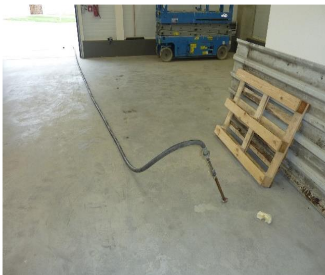
Obr. 9: Pohled na vlastní injektáž
