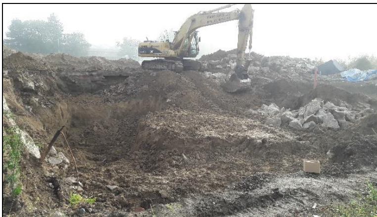
Obr. 3: Odtěžba kontaminované zeminy nacházející se v místě pod budovou bývalé chromovny
