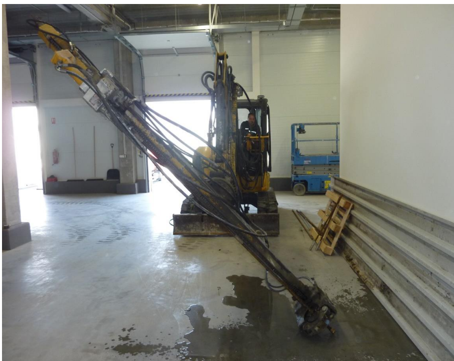
Obr. 6: Instalace sond v manipulačním skladu budovy H 12
