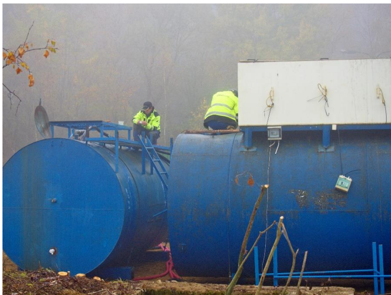
Obr. 2: Montáž sanační stanice
