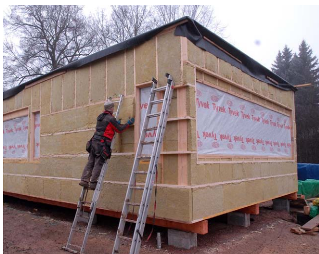
Obr. 1 – Příklad použití izolace ISOVER Akustic TP3R
