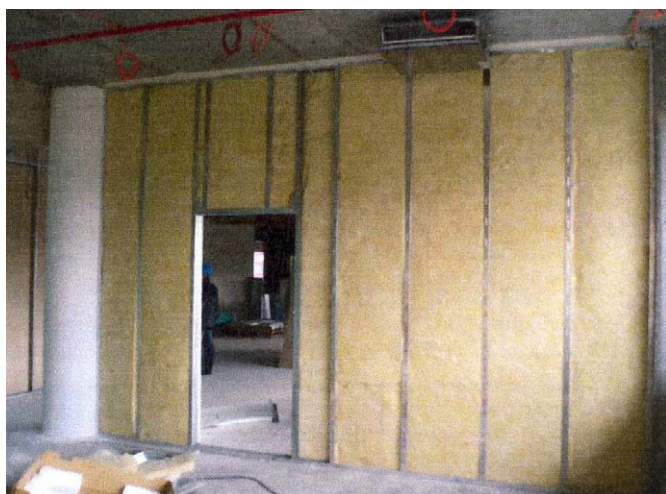
Obr. 1 – Příklad použití izolace ISOVER Aku
