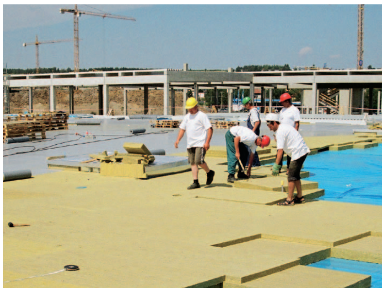
Obr. 1 – Příklad použití izolace ISOVER S
