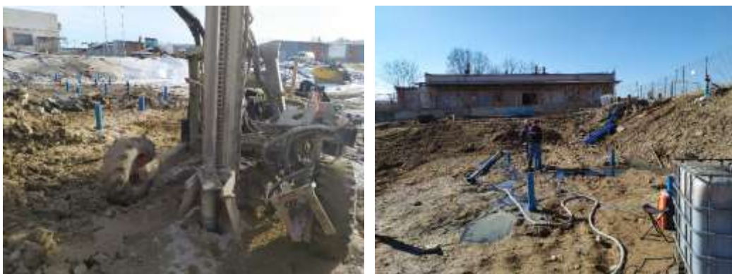
Obr.1.: a) realizace návrťů, b) tlaková aplikace suspenze nanoželeza.
