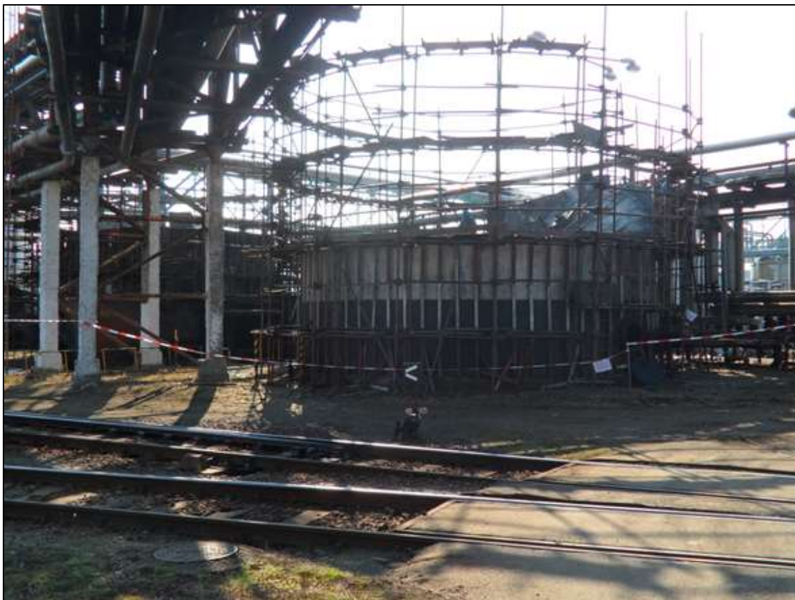
Obr. 2: Odstranění nadzemních zásobníků
