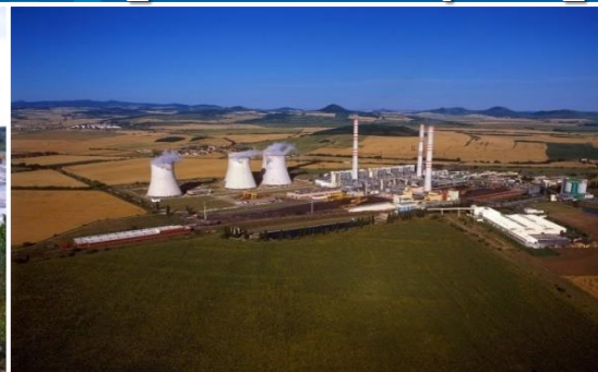
Uhelná elektrárna Počerady ( cez.cz )
