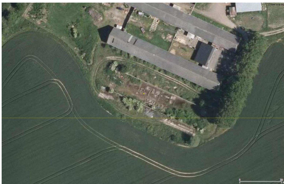
j – prázdná silážní jáma se známkami ukládání odpadu.
