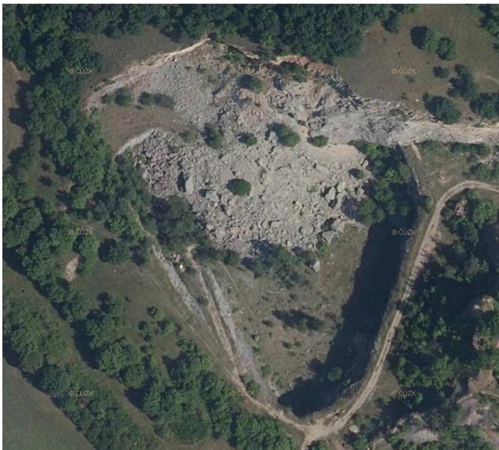
Srbsko u Karlštejna, opuštěný lom bez známek ukládání odpadu. – Neevidujeme.
