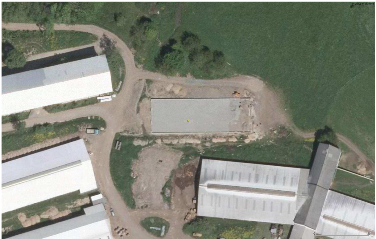
Nejde o zemědělský brownfield, objekt je využíván. Situace z r. 2014 a po renovaci v r. 2016 – Neevidujeme.
