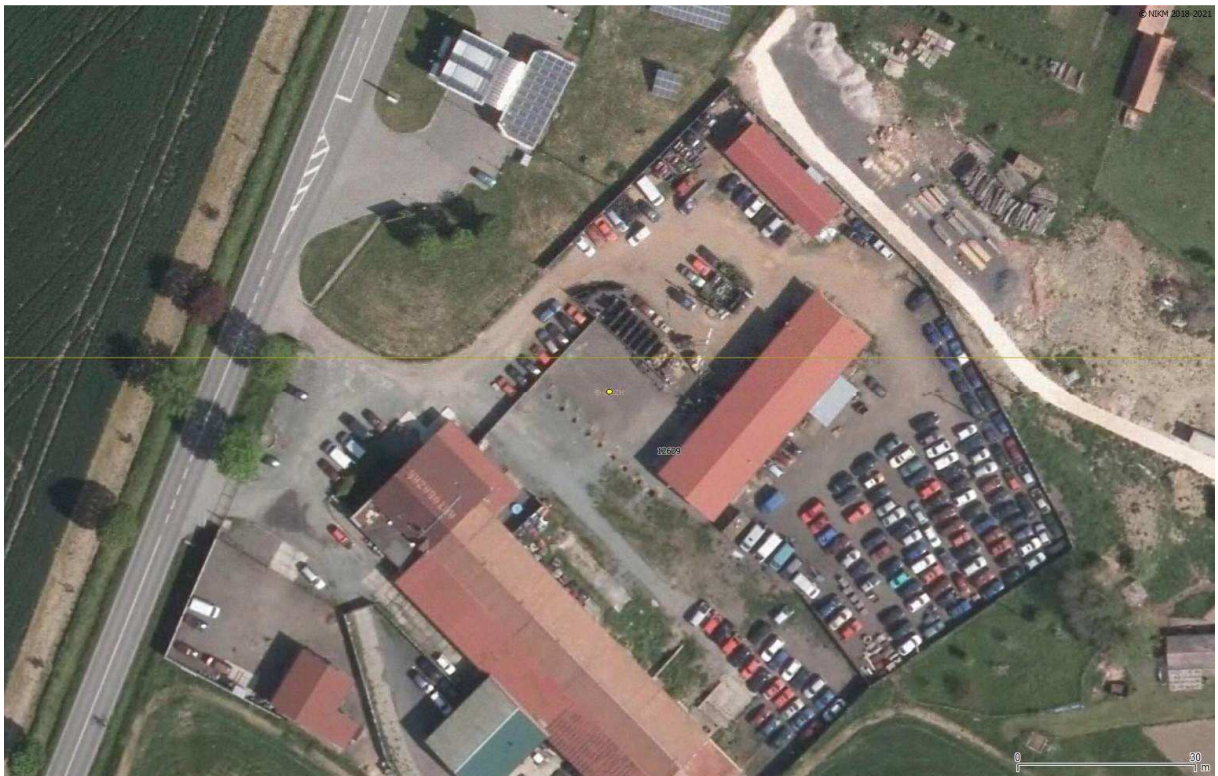
v – udržované vrakoviště aut, přesto evidujeme z důvodu možného úniku olejů
