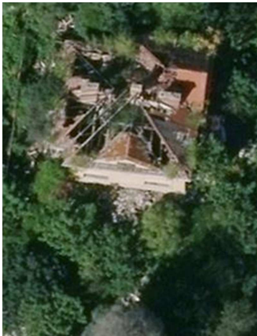
Praha, Benešovská ul. Vyhořelý rodinný dům. - Neevidujeme
