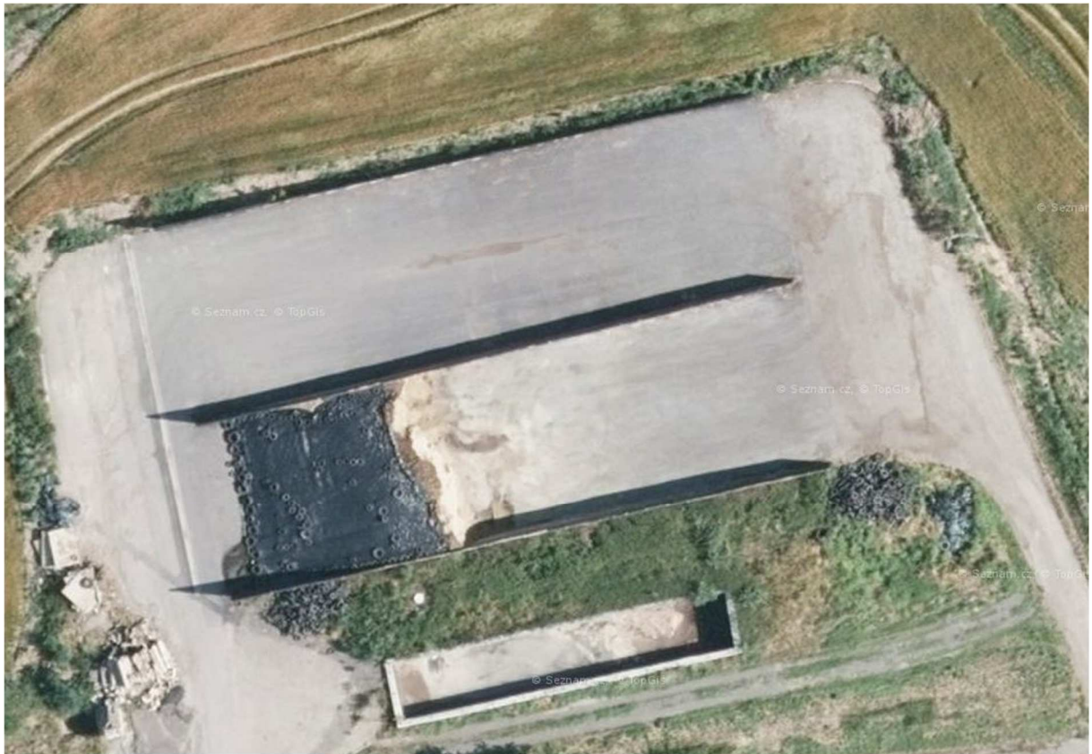
Linhartice u Moravské Třebové, užívaná silážní jáma, menší objekt níže je odtoková jímka. – Neevidujeme.
