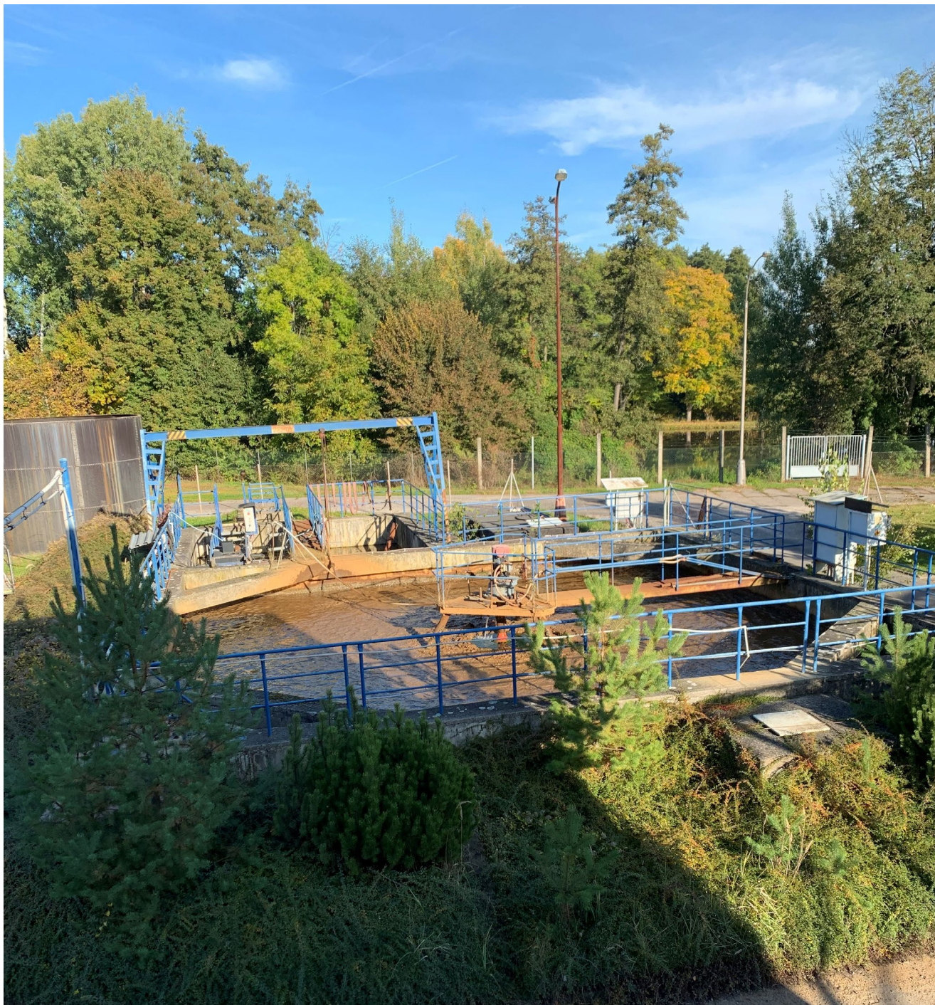
Obrázek 5: Čistírna odpadních vod.
