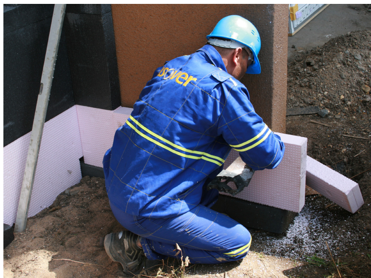
Obr. 1 – Příklad použití výrobku Isover EPS Sokl 3000
