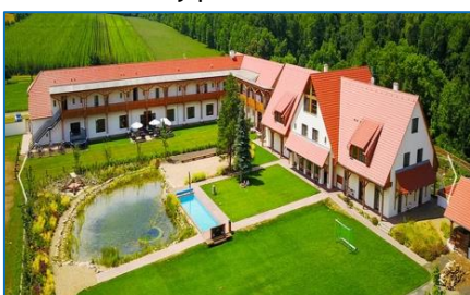
Foto 1 - celkový pohled na budovu
