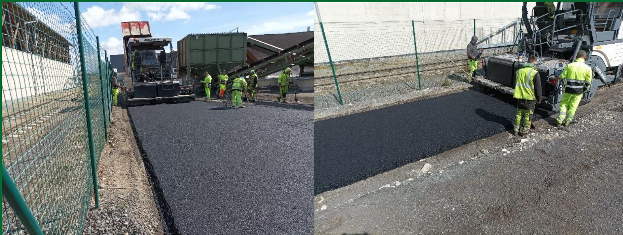
Testovací pokládka směsi ACP 16+ 50 % recyklátu
